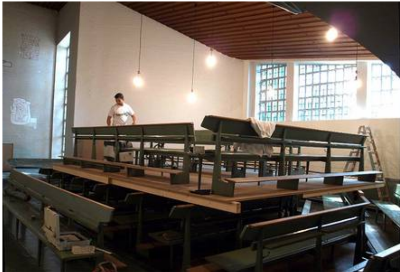
Im Vorzustand waren die Leuchten mit nur einer Fassung E 27 für Allgebrauchsglühlampen ausgestattet
